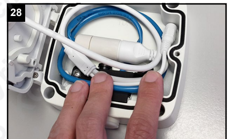
28 Legen Sie die Verkabelung vollständig in die Anschlussbox.
